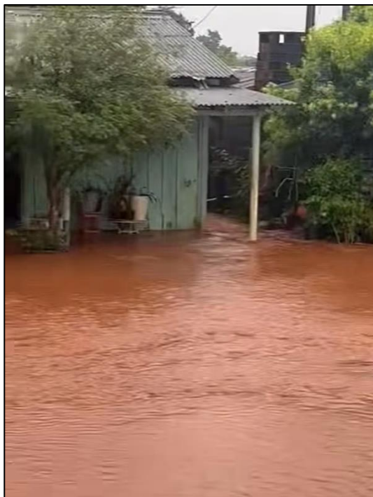
Figura 68 – Inundação no cruzamento da Rua Sete Quedas com a Rua Mauá.
