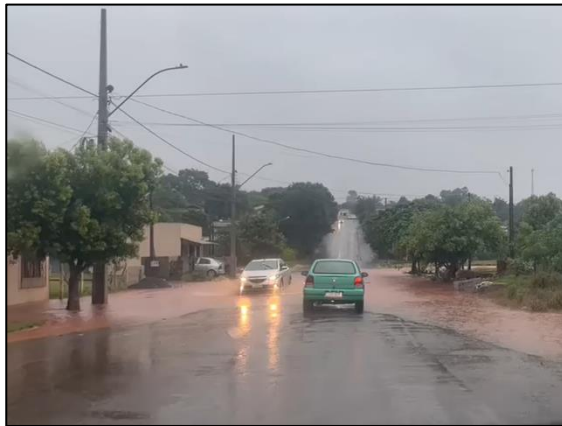
Figura 70 – Inundação na Rua Belém, próximo da Lagoa de Retenção.
